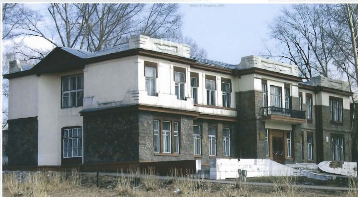
▲ Садов. Дом управляющего Кольчугинским рудником. 1914-1915. Вид до 2005 года
